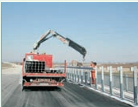
Situazione non regolare, i lavoratori sono privi di casco e il gancio dell'autogru è privo di sistema antiscacciamento
