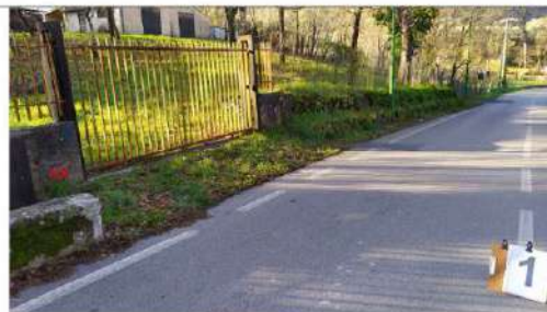
FOTO STATO DI FATTO
