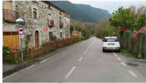
FOTO STATO DI FATTO
