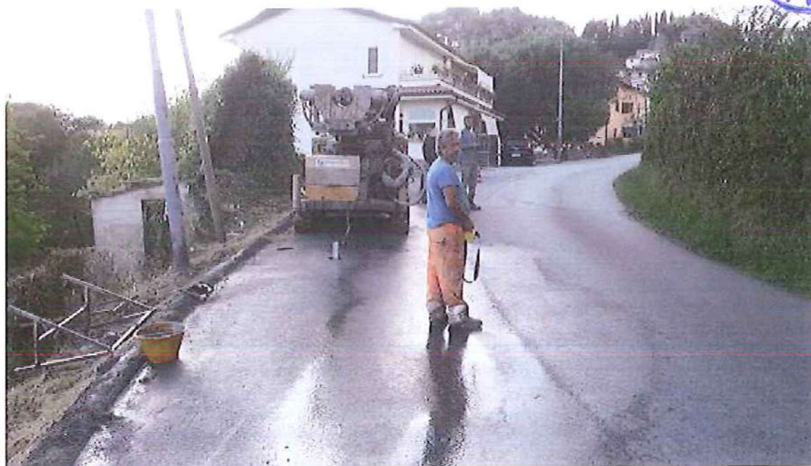
Sondaggio S1 – Pulizia area sede di indagine
