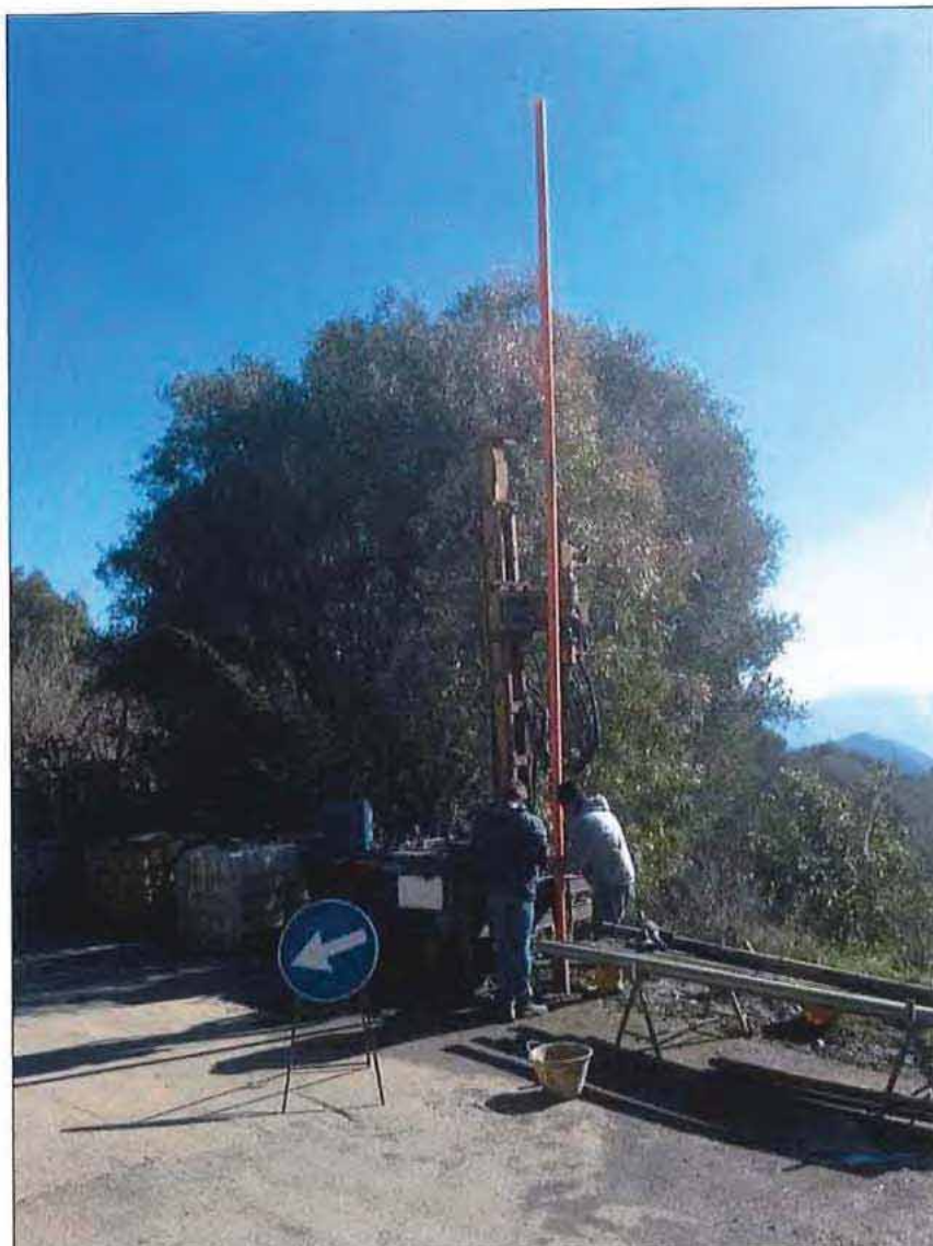
Installazione piezometro a tubo aperto in sondaggio S1
