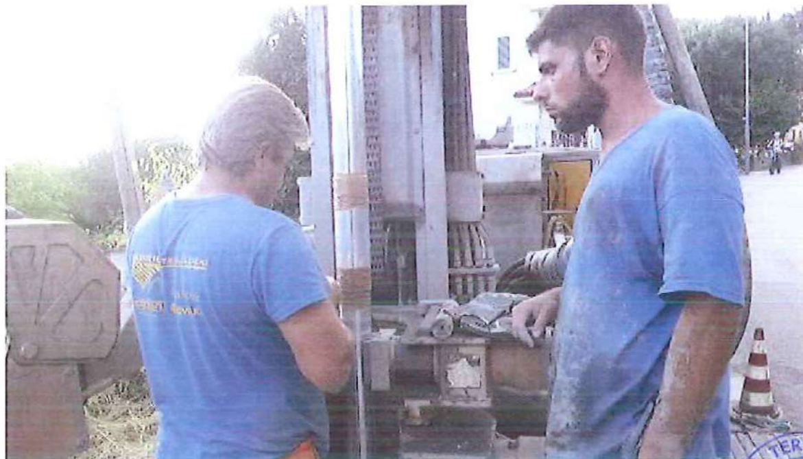
Sondaggio S1 – Posa in opera di tubazione inclinometrica
