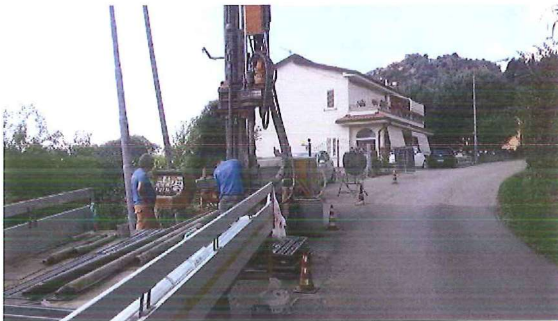
Postazione Sondaggio Geognostico S1
