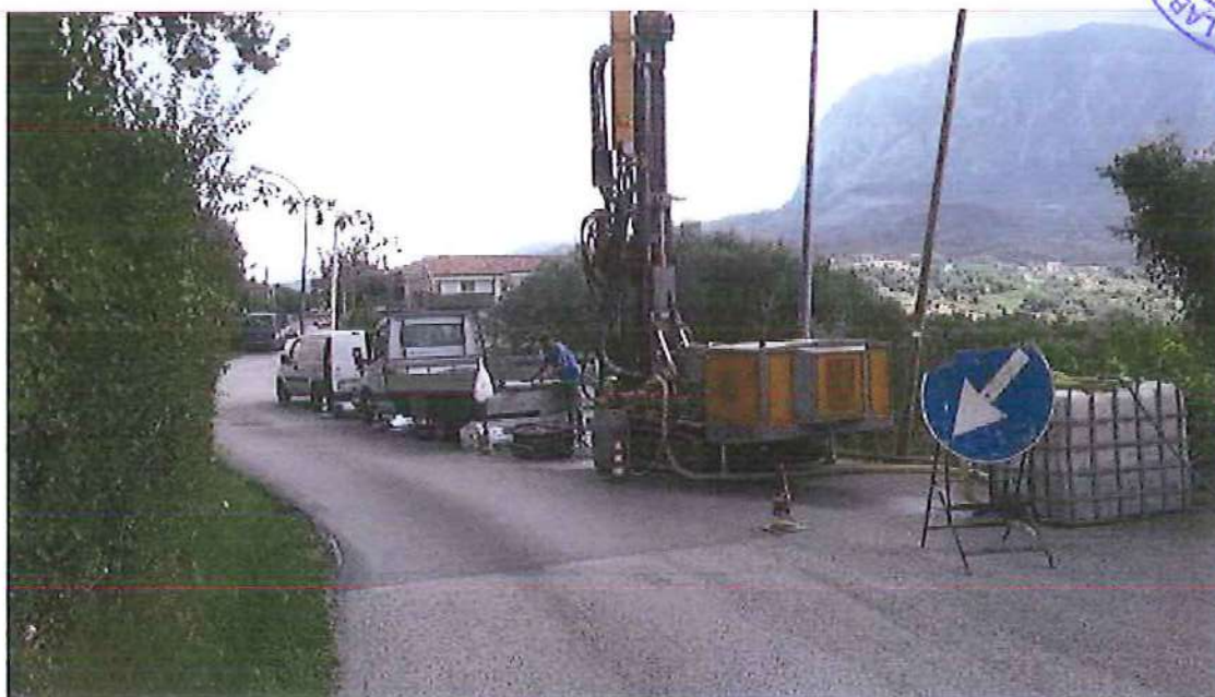
Postazione Sondaggio Geognostico S1
